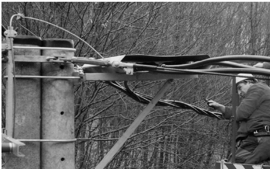
Анкерный зажим A50R+TR, установленный на системе СИП 22 кВ типа DISTRI
