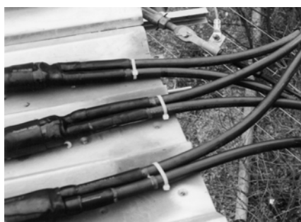
Ответительные муфты на линии СИП до 42 кВ
