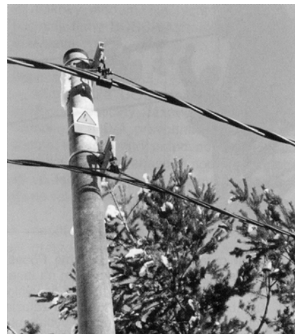
Линии СИП до 42 кВ и до 1 кВ на одной опоре
